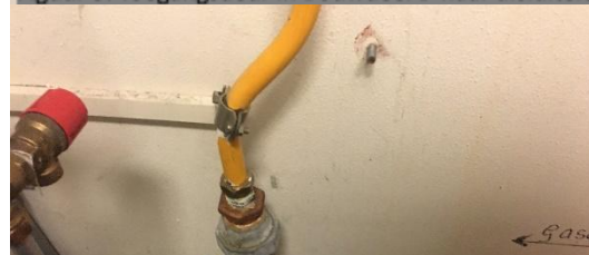
Figuur 4: De Gasafsluiter (gele hendel)
