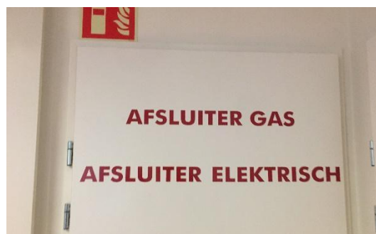
Figuur 3: Toegangsdeur in Bouwdeel D naar afsluiters
